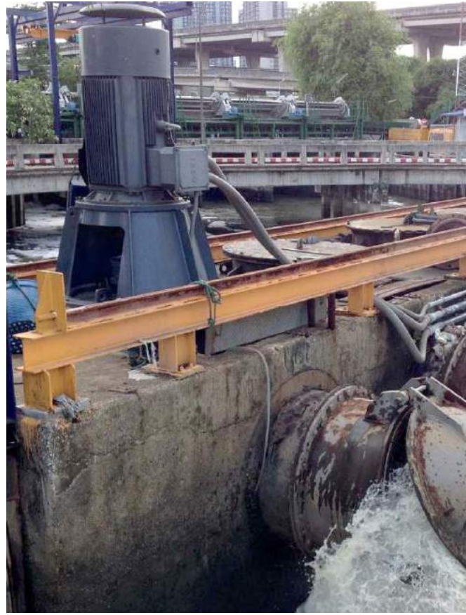
Bơm VSP tái sử dụng ống trụ thân bơm cũ của bơm chìm
